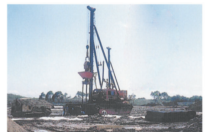
地盤改良工事
