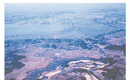
工事が完成した田村・沖宿土地区画整理事業
