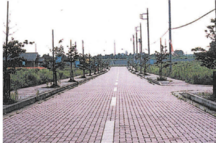
地区センター前のシンボルストリートは、蓮の花をイメージしたピンク色のブロックで舗装されています
