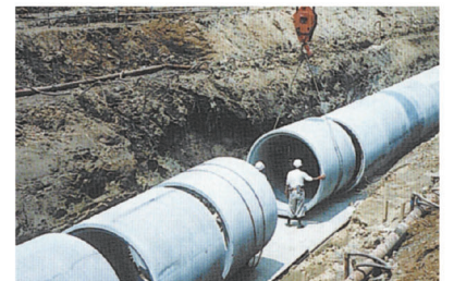
雨水排水幹線の据付け工事
